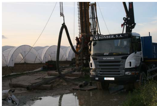
Construcción de un pozo en la zona de Matalagrana
