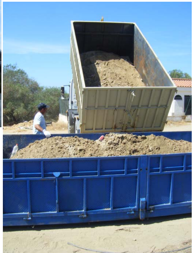
Descarga de arena contaminada por el vertido
