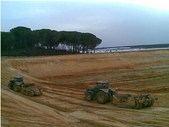
Construcción de la balsa denunciada
