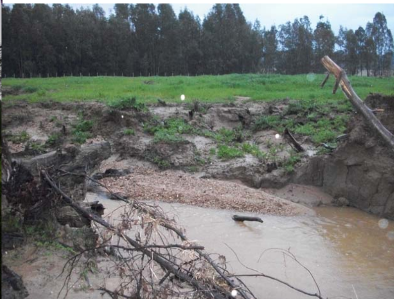
Daños en la Cañada de los Pájaros
