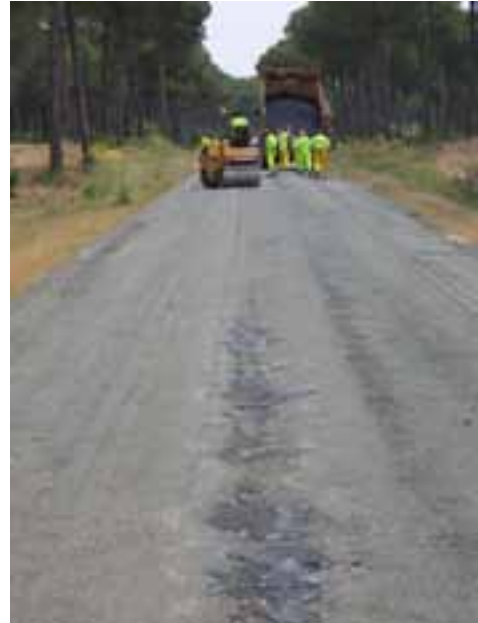
Reparación del camino del Arrayán (Hinojos-A-483).
