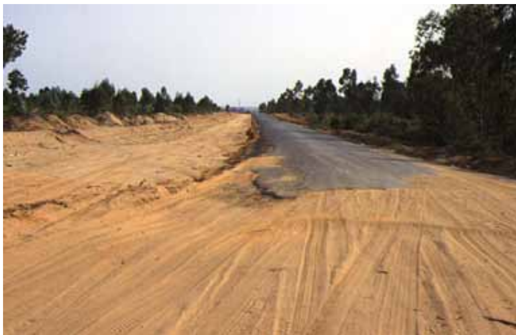
Carretera HF-6248 (Almonte-Cabezudos).
