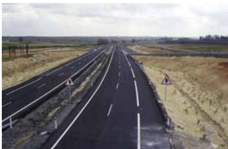
Desdoble de la A-483 (Tramo Bollullos Par del Condado-Almonte).
