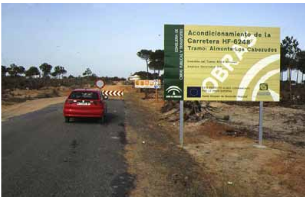
Carretera HF-6248 (Almonte-Cabezudos) en construcción, financiada con fondos del PSDS.
