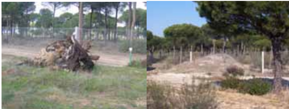
Infraestructuras para facilitar la huida de los mamíferos de las carreteras valladas. Izqda. Camino Villamanrique-A-483. Drcha. A-494 (Tramo Mazagón-Matalascañas).
