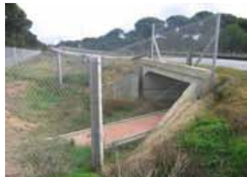
Paso de fauna del Camino Villamanrique-A-483
