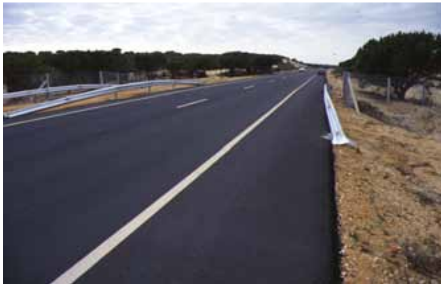
Carretera A-494 (Tramo Mazagón-Matalascañas).
