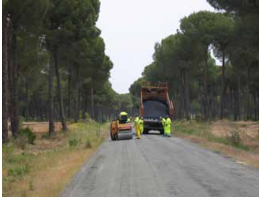
Obras de reparación del asfalto del camino del Arrayán (Hinojos-A-483) en mayo de 2006, días antes de la celebración de la Romería del Rocío.
