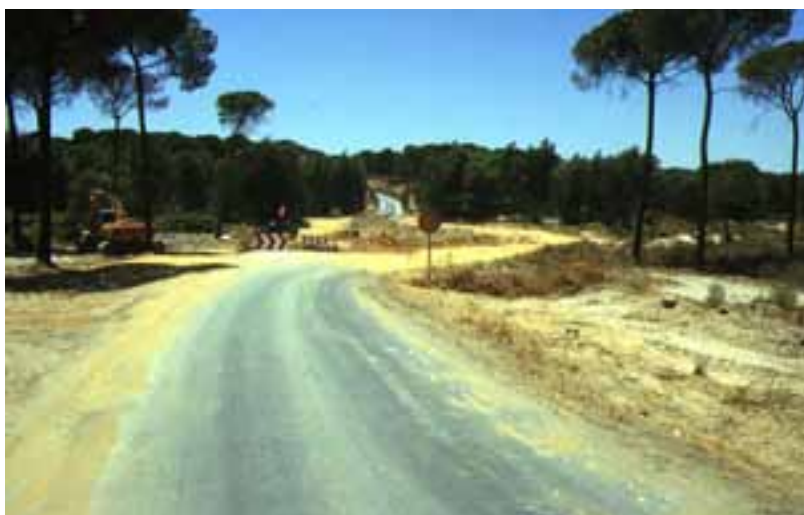
Obras en el camino forestal de Cabezudos.
