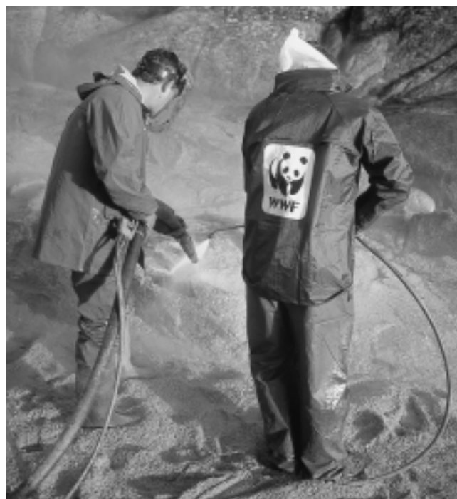
Prueba con máquinas de agua a presión.
