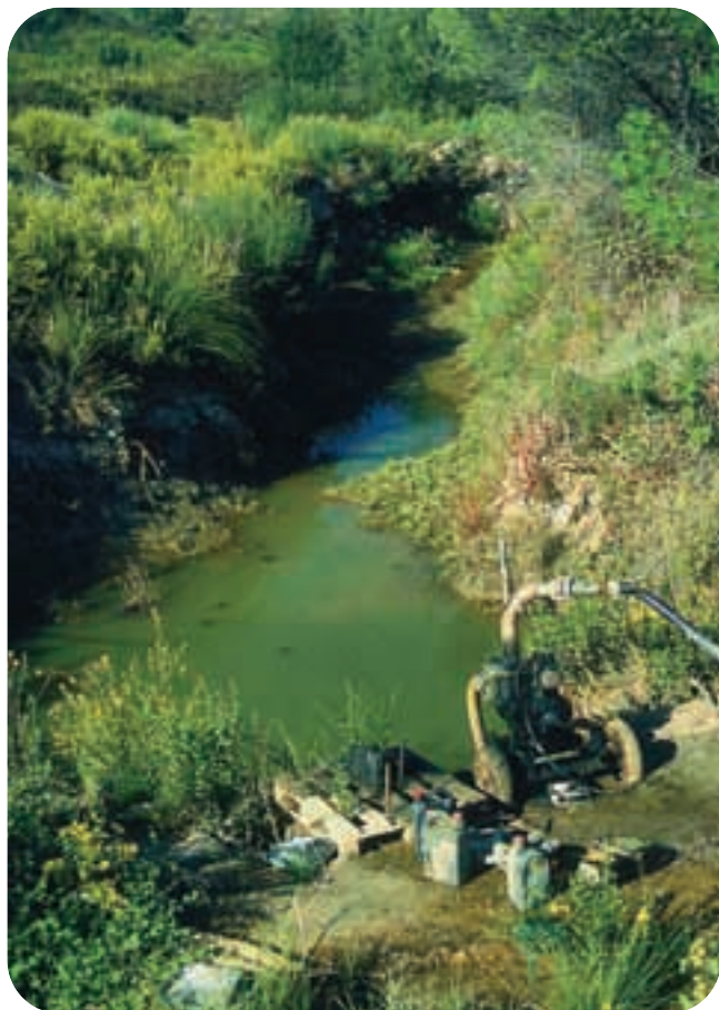
Toma de agua en el arroyo del Alamillo.
